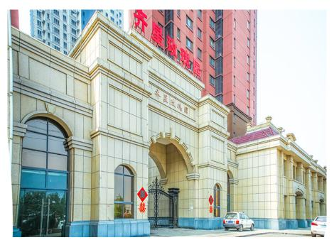
真石漆和乳胶漆的区别。装饰效果不同:真石漆立体感强,乳胶漆要求的是平整度。乳胶漆做出的是平整光洁的保护层,而真石漆是一种装饰效果酷似大理石、花岗岩的涂料。主要采用各种颜色的天然石粉配制而成,应用于建筑外墙的仿石材效果,因此又称液态石。真石漆装修后的建筑物,具有天然真实的自然色泽,给人以高雅、和谐、庄重之美感,适合于各类建筑物的室内外装修。特别是在曲面建筑物上装饰,生动逼真,有一种回归自然的效果性能不同:真石漆是复层涂料,同底漆、防水面漆组成。是以纯丙烯酸聚台物及天然彩砂为原料,涂层坚硬,粘结性好,耐用时间超长,防污性好,阴阻燃,耐酸碱。乳胶漆用于涂刷于建筑外立面,所以\*\*重要的一项指标是抗紫外线照射,要达到长时间照射不变色。要求有抗水性能,要求有自洗性。漆膜要硬、平整、脏污一冲就掉。
