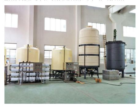
塑料储罐特点:1□PP储罐整体造型美观、无焊缝、无渗漏、抗冲击性强、抗拉强度高、抗氧化、抗老化性能
